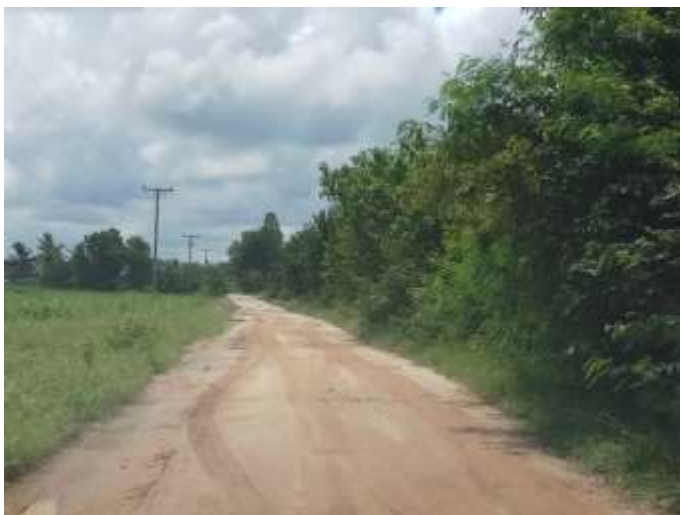
๘. โครงการก่อสร้างถนนคอนกรีตเสริมเหล็ก (คสล.) หมู่ที่ ๖
