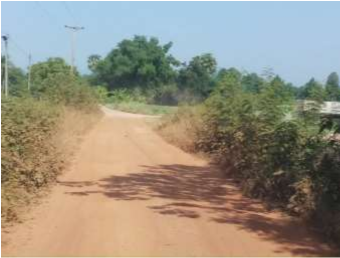
๗. โครงการก่อสร้างถนนคอนกรีตเสริมเหล็ก (คสล.) หมู่ที่ ๕
