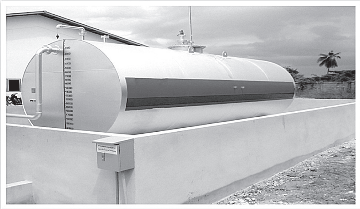
รูปที่ ๒ สถานที่เก็บรักษาน้ำมันเชื้อเพลิง ลักษณะที่ ๒ (โรงงานขนาดเล็กหรือเพื่อการเกษตร)
