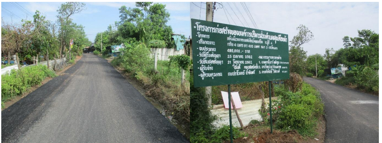
โครงการเสริมผิวจราจรแอสฟัลท์ติกคอนกรีตหมู่ที่ ๔
